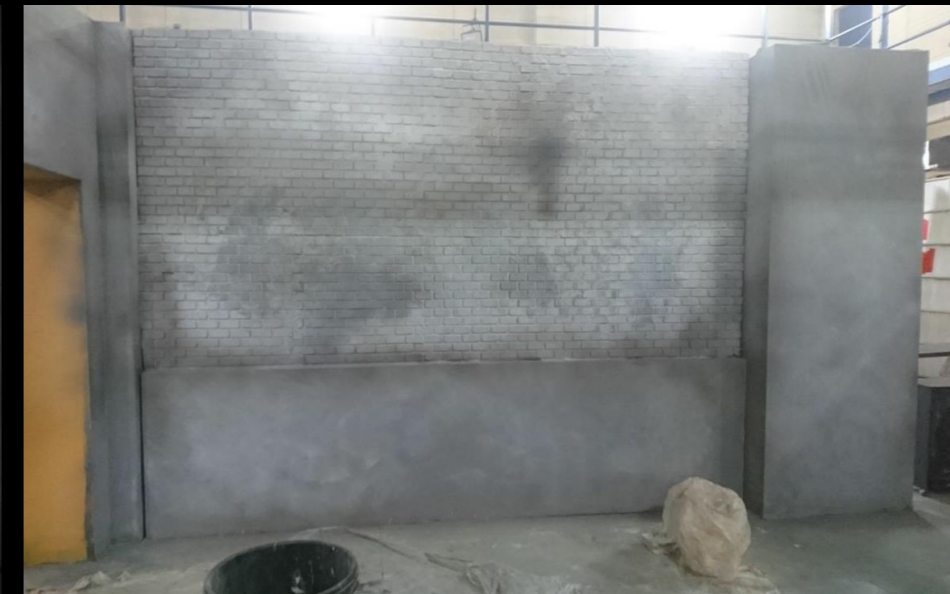
Fig. 03 - Interior Sótano Luismi - Construcción
