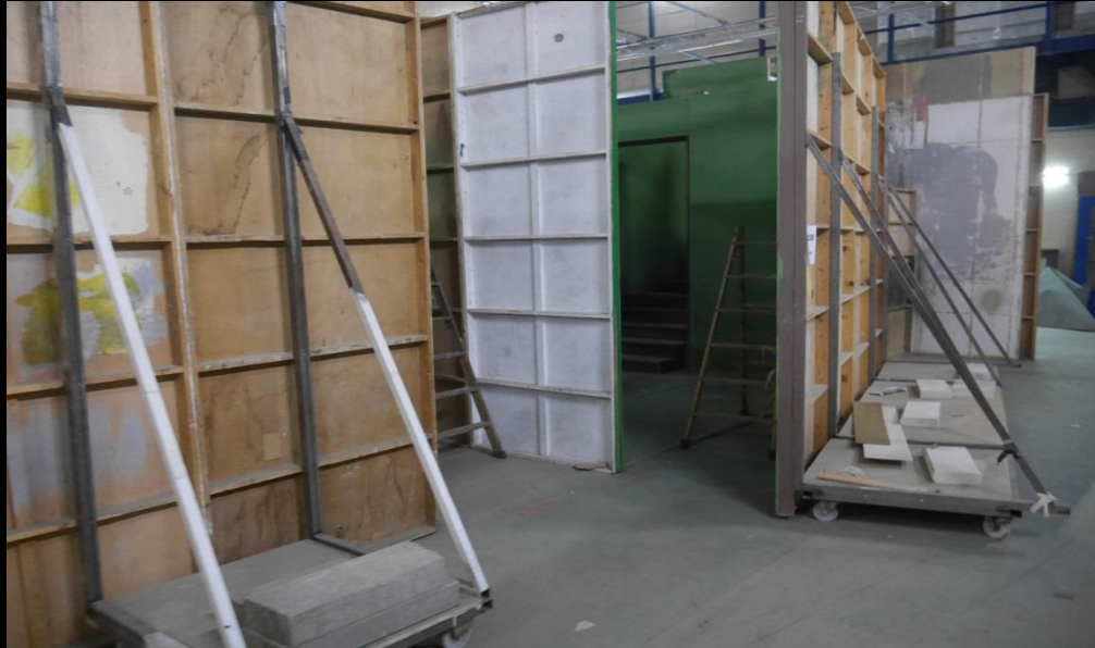
Fig. 01 - Interior Sótano Marisa - Construcción
